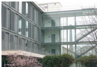
19. La cheminée vue à travers la passerelle du nouveau bâtiment
