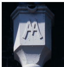
15. Cuvette en fonte d'un tuyau de descente d'eaux pluviales
