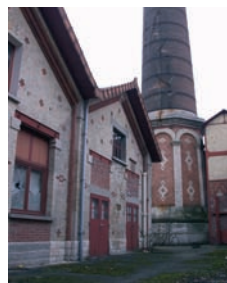
16. Les bâtiments techniques autour de la cheminée
